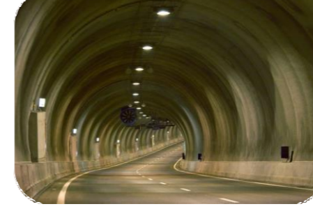
Les infrastructures souterraines الأنفاق
