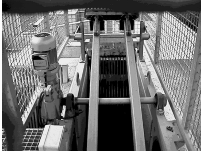
Fig. 5.1 – Dégrilleur courbe
