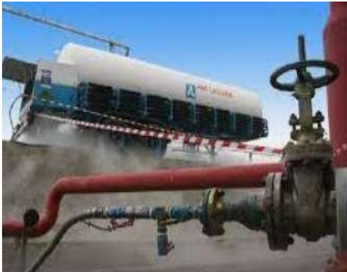
Figure 6 : Installation de l'inertage et schéma d'injection d'azote
