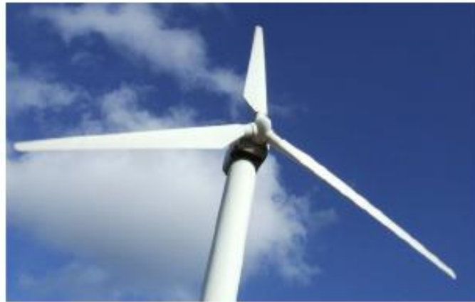
Figure I.10 : Un rotor d'une éolienne à axe horizontal.
