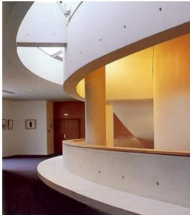
Figure I.11 Béton auto-plaçant [29].
