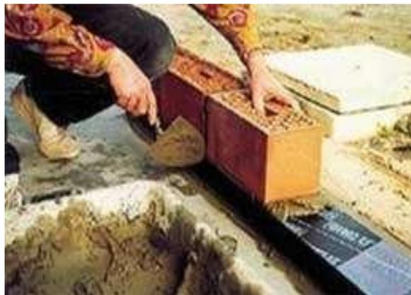
Figure VI.9 Bloc de verre cellulaire servant à créer une barrière étanche entre sol et parois maçonnées.
