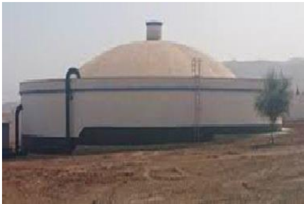
Figure 21. Réservoir semi enterré
