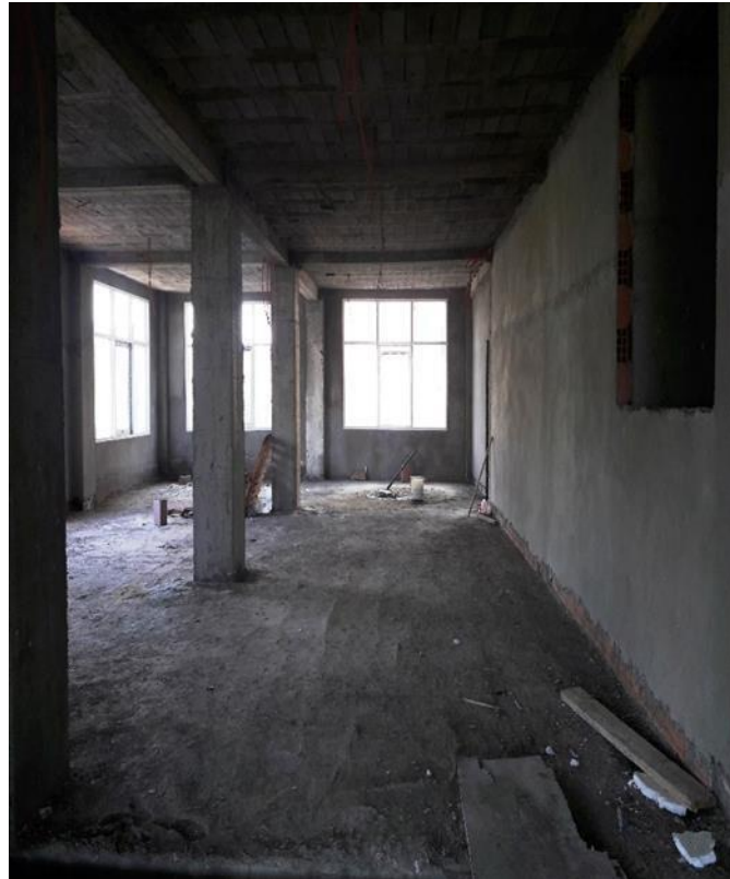
Un vitrage, l'aération et l'éclairage d'un local
