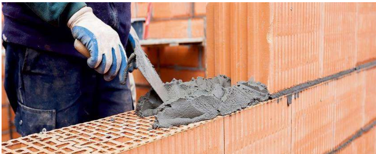
Figure 4.1. Joints de maçonnerie.
