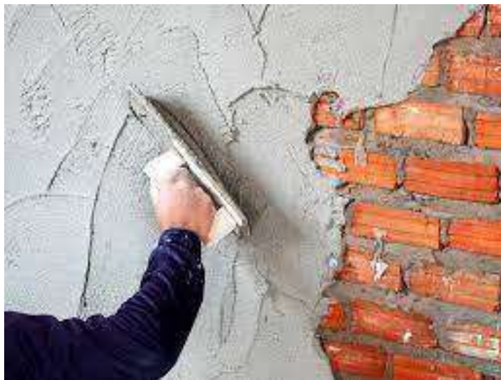
Figure 4.3. Application d'enduit.
