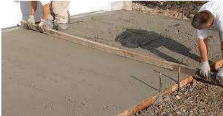
Figure 4.2. Application d'enduit pour chape.
