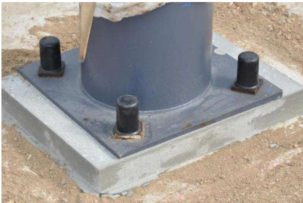
Figure 4.4. Calage d'un poteau en charpente métallique.
